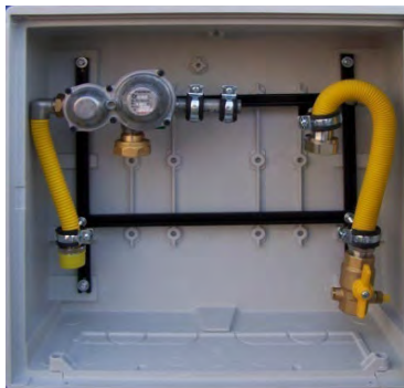
Regulátor tlaku plynu Fisher/Francel B6 NG 6 m3/hod
