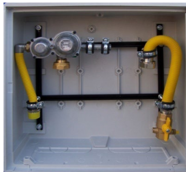
Regulátor tlaku plynu Fisher/Francel B6 NG 6 m3/hod
