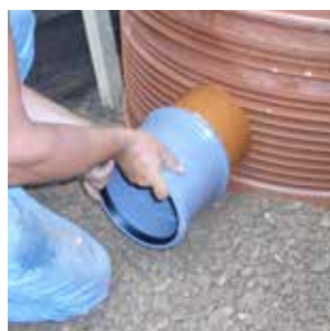
Flexibilní hrdlo Obr. 16
