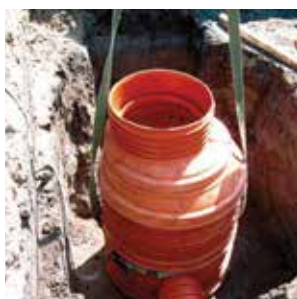
Šachta ve výkopu Obr. 15
